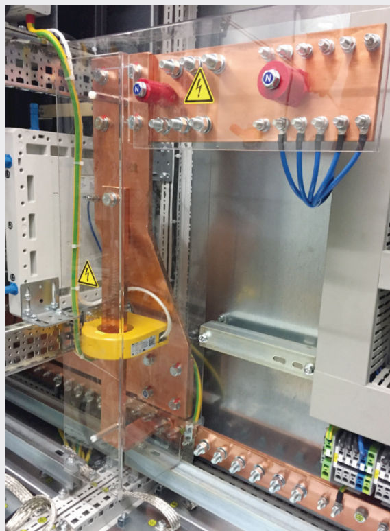
ZEP-Überwachung mit einem Differenzstromsensor von Bender
