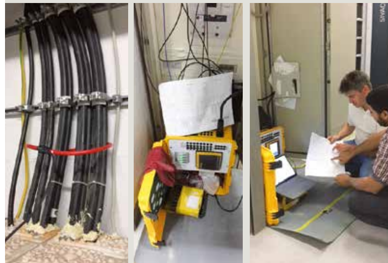
Messungen mit dem PEM735-Messkoffer von Bender
